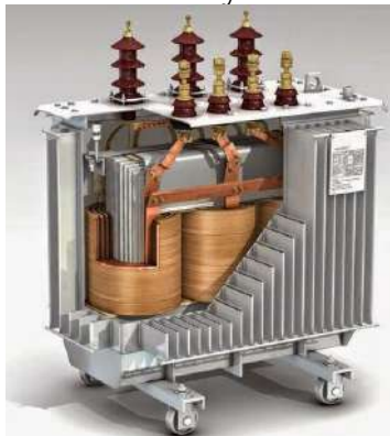
Рис. 3.27. Внутрішня будова силового трансформатора
